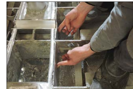
▲ Mise en place des doublantes de 4 mm entre chaque varangue.
