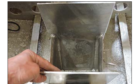
▲ Encastrement du nouveau puisard fabriqué sur mesure s'il vous plaît!
