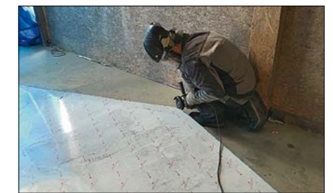
▲ Préparation à la meuleuse des tôles en aluminium qui serviront à réaliser la doublante.
