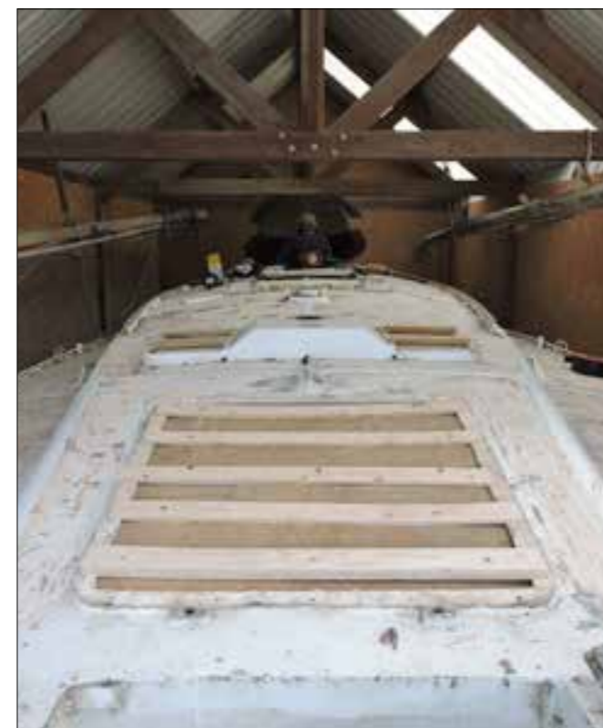
▲ Tout ce qui pouvait être démonté l'a été, et le reste a été soigneusement protégé : le pont est fin prêt pour le sablage.
