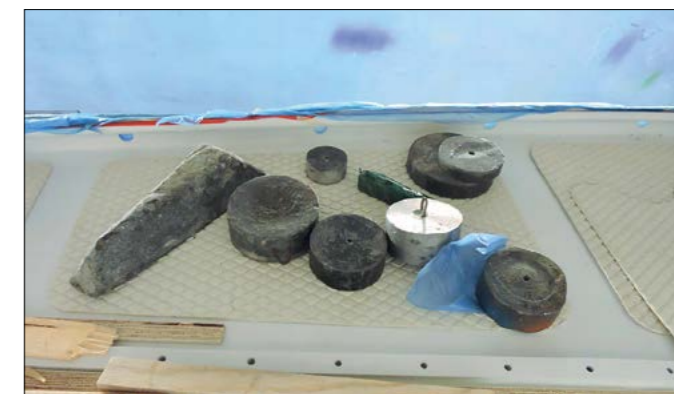
▲ Dernière étape : on dispose des poids sur l'antidérapant pendant 36 heures pour parfaire le collage du Trade Master.
