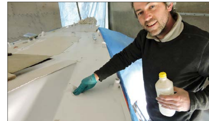
▲ A l'instar de tous les supports, celui-ci doit être parfaitement préparé (dépolié et dégraissé) pour une meilleure adhésion de la colle époxy.
