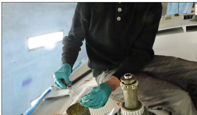
▲ On badigeonne les vis d'une pâte isolante pour prévenir la corrosion entre l'inox des vis, l'aluminium du pont et le milieu salin.
