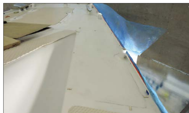
▲ Les contours des panneaux à venir ont été dessinés à partir des gabarits et des petites cales installées pour éviter tout ripage au moment de la pose.
