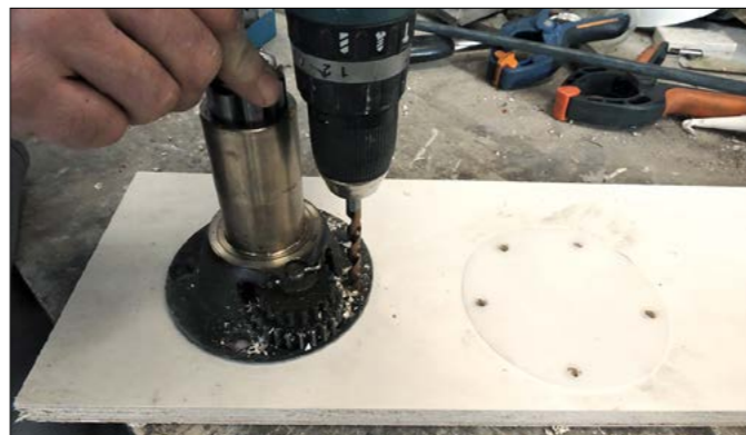
▲ Il ne reste plus qu'à percer les futurs trous de vis dans ces nouveaux supports isolants avant de finaliser le montage des winches.
